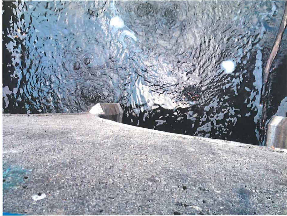
Widok na wypływ poniżej mostu
