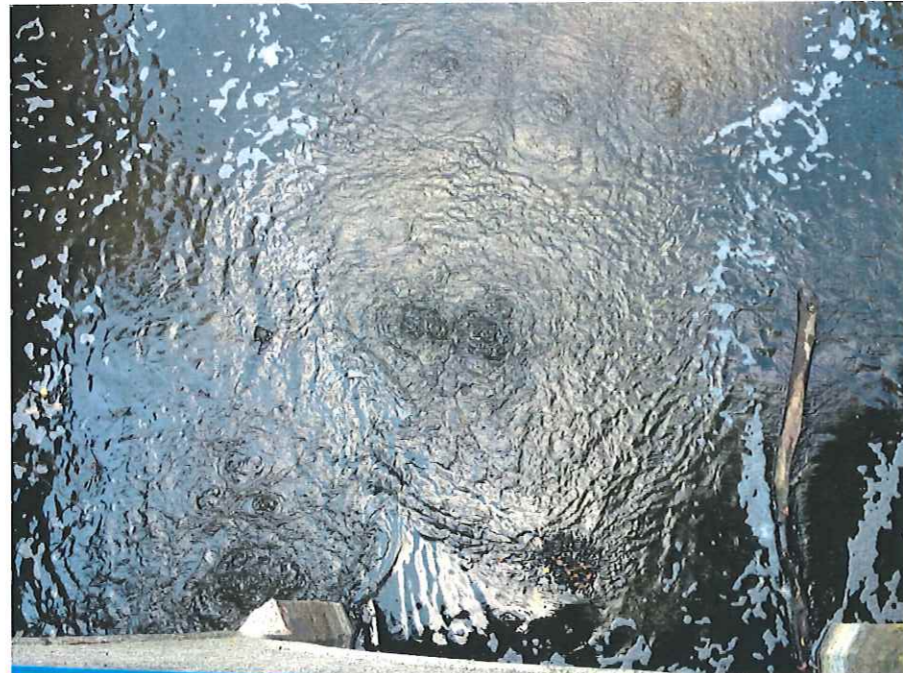
Widok na wypływ poniżej mostu
