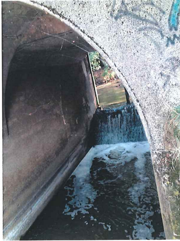
Widok od wody dolnej na przelew przez próg jazu stałego przy rzędnej zwierciadła wody ~198,50 m nKr.
