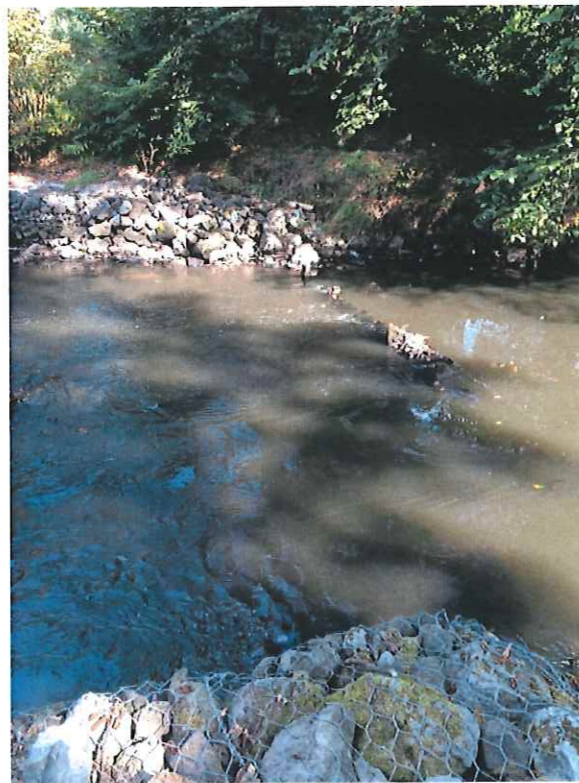
Widok na umocnienia skarp i dna od wody górnej
