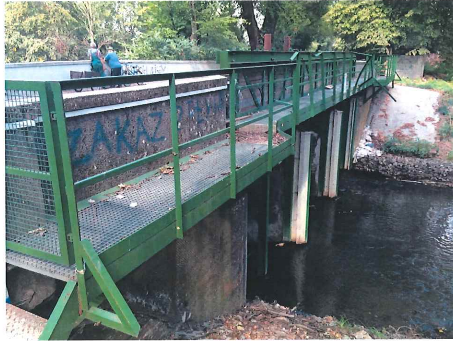
Widok urządzenia od wody spiętrzonej na rzędnej około 198,50 m n Kr. Z kładką do obsługi zasuw
