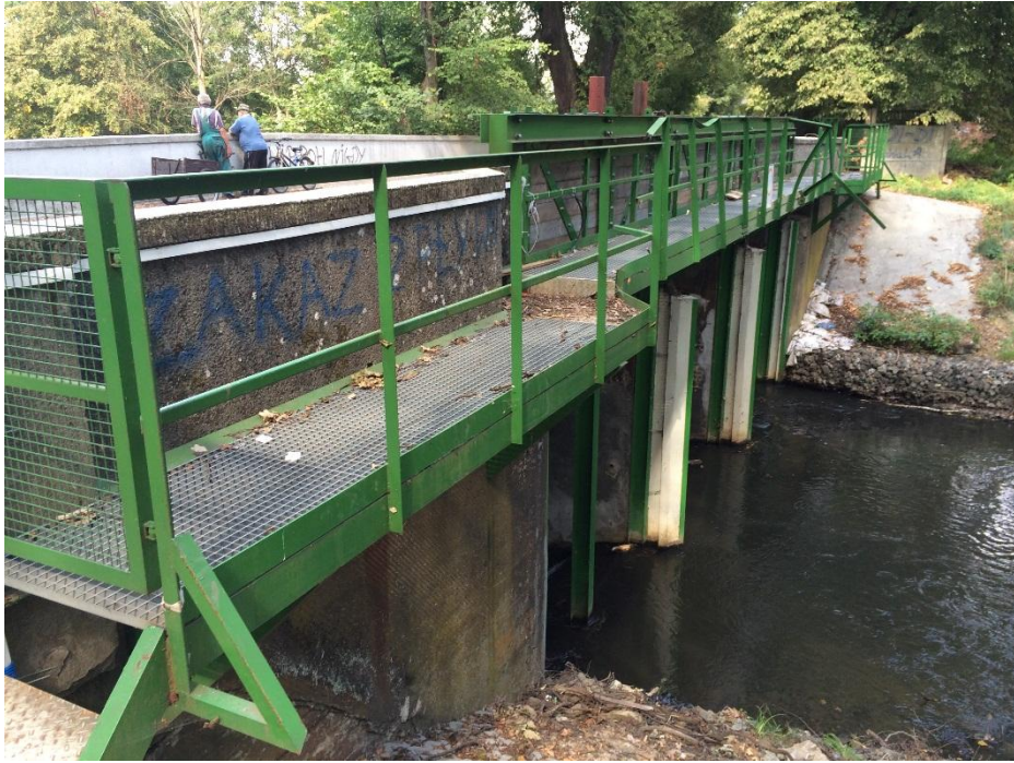
Widok urządzenia od wody spiętrzonej na rzędnej około 198,50 m n Kr. Z kładką do obsługi zasuw
